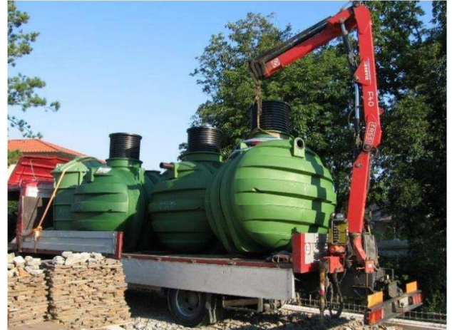
1 sz. Kép: Megfelelő szállítás és lepakolás
