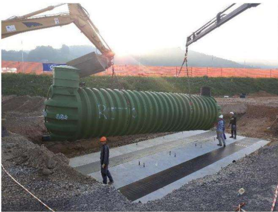
4. sz kép: A tartály telepítése
