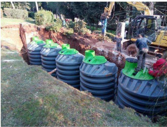
5.sz. kép: Tartályok sorba telepítése
