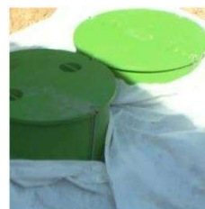
Amikor a tartályokat a terepszinttől 20 - 30 cm-re temették el, fektesse le a geotextíliát
