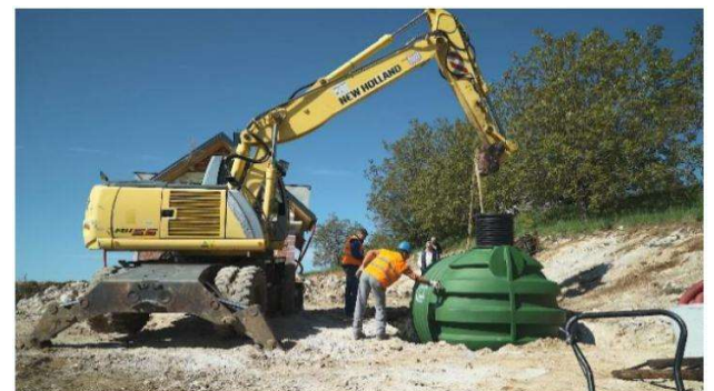
3. sz. Kép: A tartály telepítése
